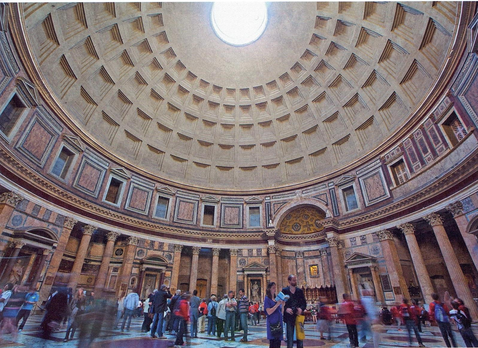
Die freitragende Kuppel des Pantheon in Rom ist eine der größten der Welt – ihr Innendurchmesser beträgt 43,30 Meter. Das Dach des 1900 Jahre alten Tempels besteht aus dem antiken Beton Opus caementitium, der aus statischen Gründen zur Öffnung hin immer dünner gegossen worden.
